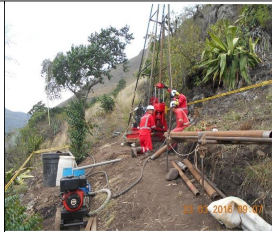
PR 43+500: Actividades de perforaciones para estudios de detalle del Proyecto.
