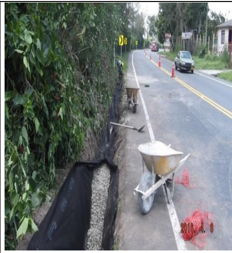
Construcción de Filtro
