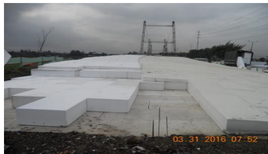
Puente vehicular Terraplen costado occidental
