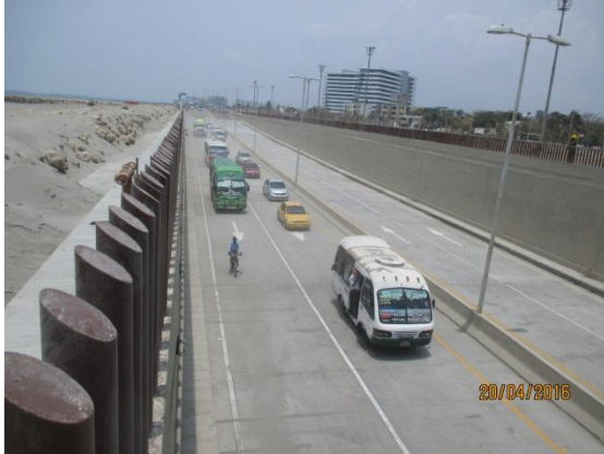
Túnel de Crespo en servicio
