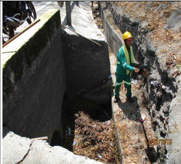
Limpeza de Obras de drenaje
