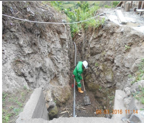
PR 48+270: Limpieza de Alcantarillas.
