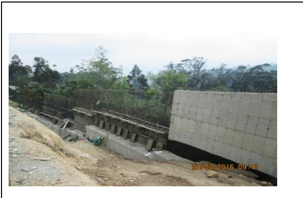
Tramo 4A, K34+430-K34+525 Muro 8A-3B en Construcción los módulos por el costado derecho.
