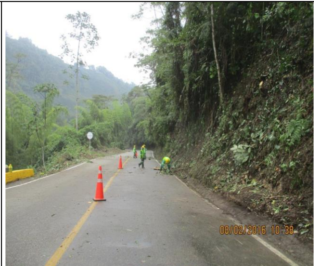
Limpeza de las márgenes de la vía.
