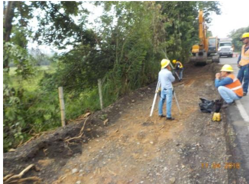
PR 17+030 - PR 17+300, Comisión topográfica revisando nivelación de la excavación, costado izquierdo. UF1
