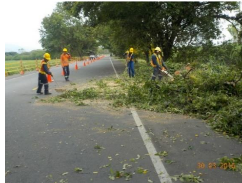
PR 12+800 - PR 13+000, tala de árboles y ramajeo.
