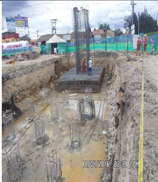
Amarre de acero de refuerzo de la zapata 1; Glorieta Mosquera - La Mesa
