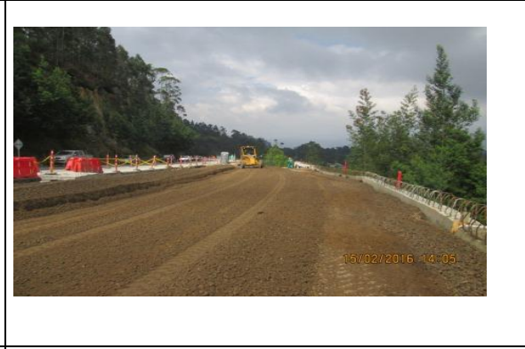
Tramo 4A, K34+290-K34+410 Instalación de subbase granular por el costado derecho
