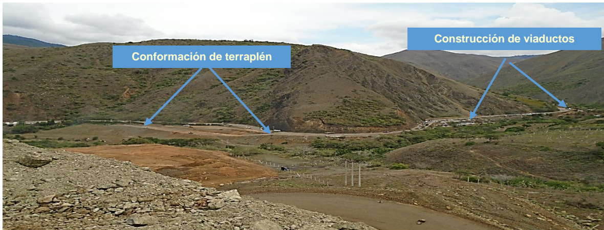
Fotografía No. 1. Panorámica del sector de Loboguerrero donde se observa el proceso de construcción de segunda calzada de manera paralela a la calzada existente, mediante conformación de terraplenes y construcción de viaductos.
