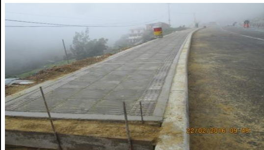
Tramo 4B. K31+820-K32+180 Construcción espacio público. Costado derecho
