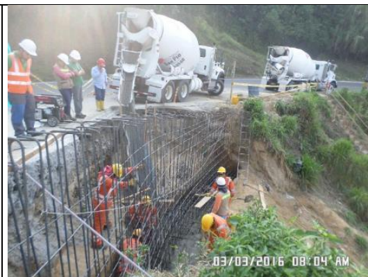
Trabajos Punto critico UF5 PR 31+150
