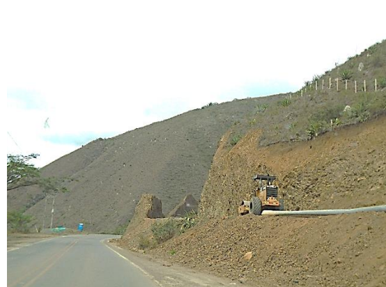
Fotografías No. 4 y 5. Corte de taludes para segunda calzada paralela a la calzada existente.
