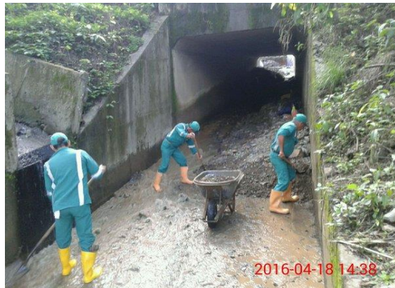
Mantenimiento rutinario – Limpieza de box culvert (UF 4)
