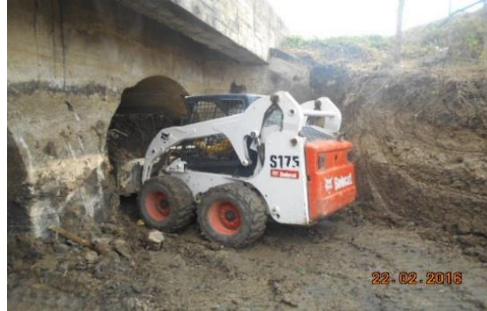
Actividad de limpieza de alcantarilla
