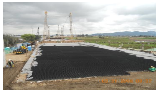
Terraplen costado oriental
