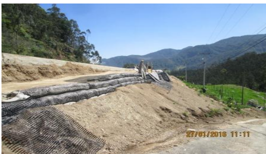
Tramo 4B. K32+090-K32+180 Construcción de muro mecánicamente estabilizado. Costado derecho.
