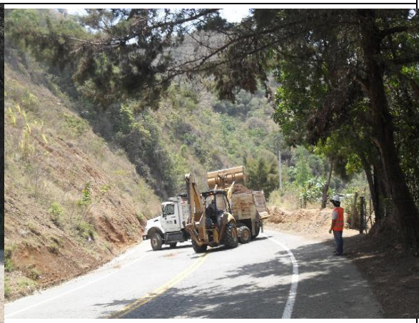
Remoción de Cuñas de Derrumbe Ruta UF2
