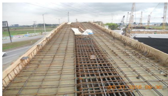
Puente peatonal; Colocación de acero de refuerzo pasarela, pendiente su fundida
