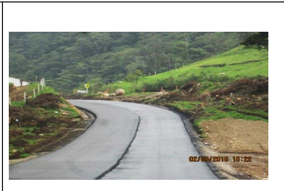
Tramo 4A, K36+820-K37+090 Instalación de MDC 2. Costado derecho
