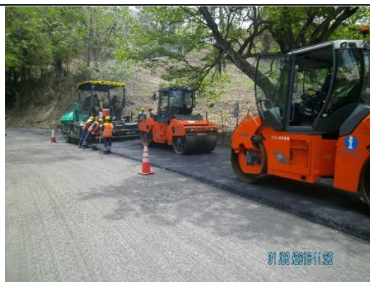
Rehabilitación Unidad Funcional 5 vía Pintada-Primavera.
