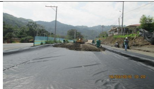
Tramo 3.1. K53+260-K53+400 Instalación de geotextil tejido y material de mejoramiento. Costado izquierdo.
