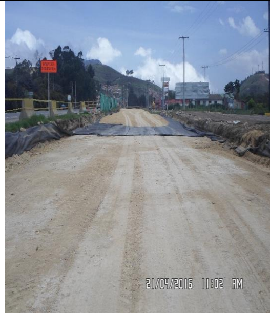
Extendido de material Base Granular. K22+460 - K22+540.
