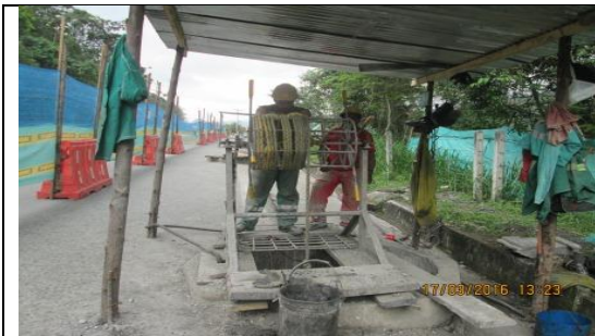
Tramo 2. K62+764-K62+849 Construcción de caisson. Costado izquierdo
