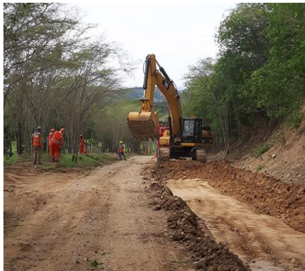
Unidad Funcional 4 Excavación, y relleno en materiales granulares
