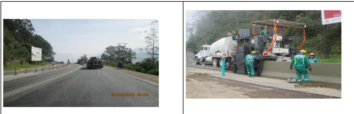
Tramo 4B. K32+230-K32+350 Instalación de MDC 1. Costado derecho
