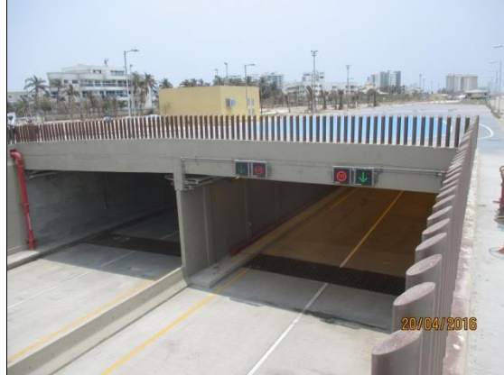
Túnel de Crespo
