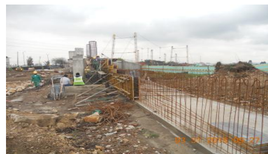
Construcción muros rampa conectante Lisboa.
