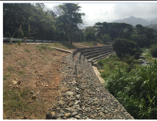
Obras de protección en el sector Rio Piedras PR23+900 ruta 9008
