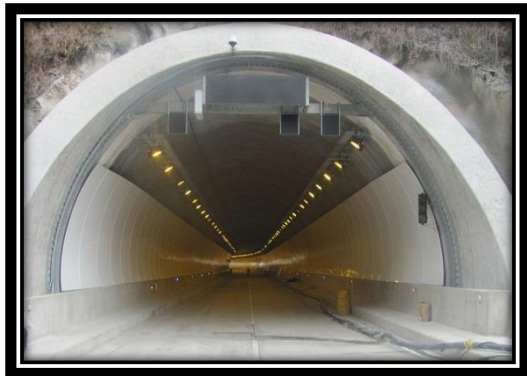
Túnel 5 K42+246.3-K42+488.2 (L=241,9m)
