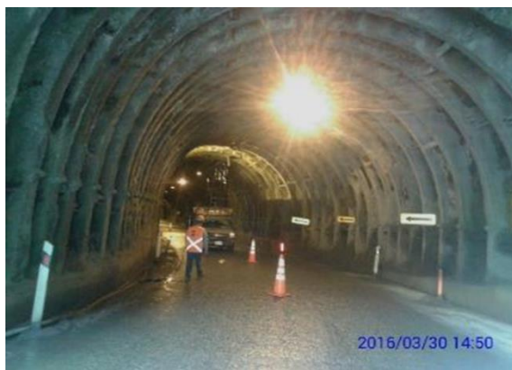
Mantenimiento de iluminación túnel el salitre Unidad Funcional (UF 3)
