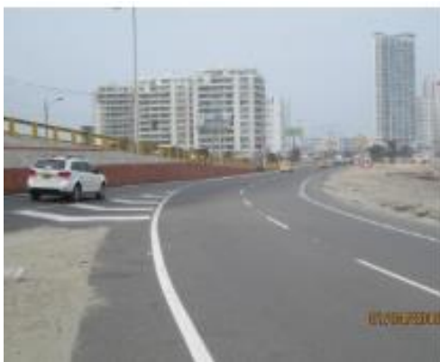
Intersección con Puente Av Santander
