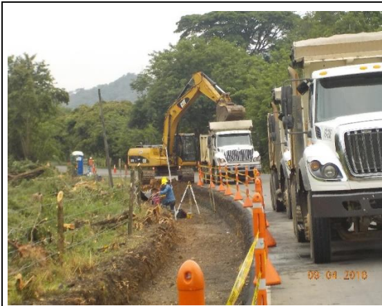
PR 17+030 - PR 17+300, cajero para ampliación vía, costado izquierdo. UF1
