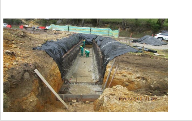
Tramo 4A. K33+520 Construcción pasa ganado - fundida placa de piso. Costado derecho
