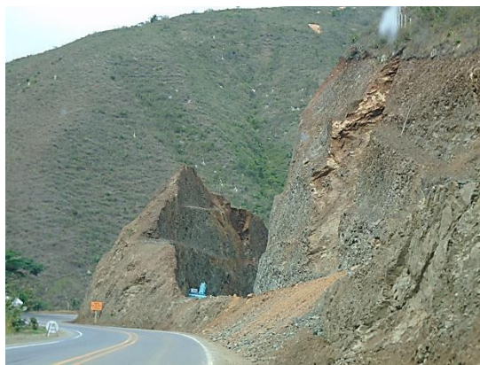
Fotografías No. 4 y 5. Corte de taludes para segunda calzada paralela a la calzada existente.
