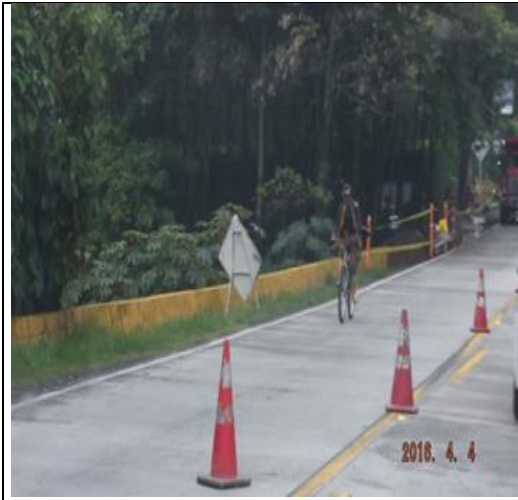
Obras y actividades de la rehabilitación de la Española-Calarcá
