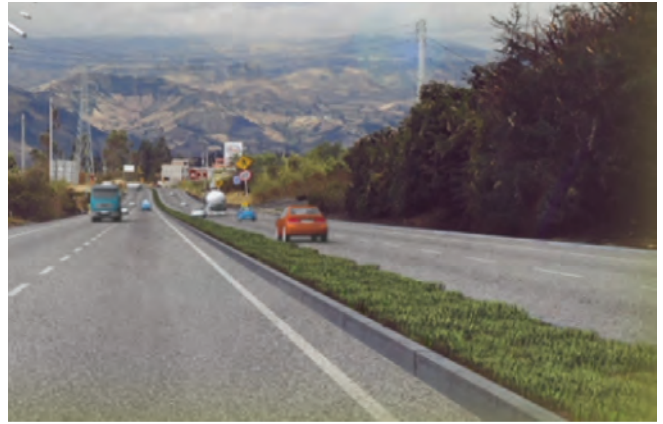
Se incorporarán tecnologías de información para la gestión del tráfico y supervisión permanente del estado de la carretera.
