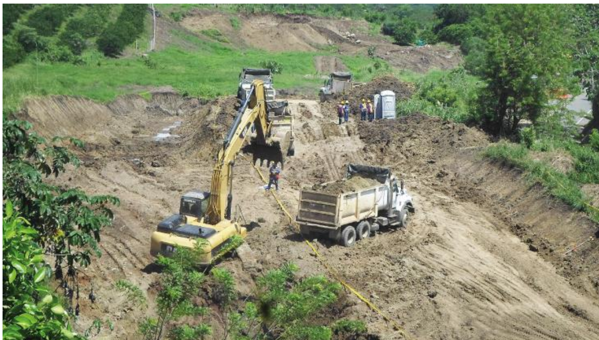
Avanzan obras en Pacífico 2
