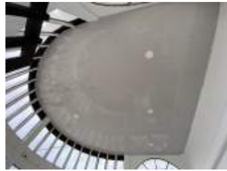
Edificio administrativo - Cubierta
