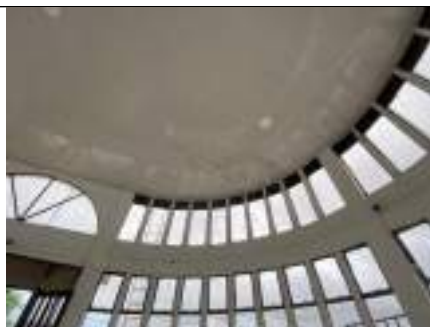
Edificio administrativo - Cubierta
