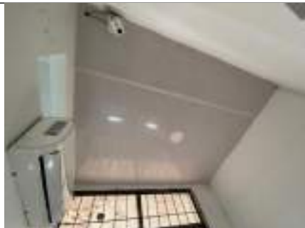
Edificio administrativo - Taquillas
