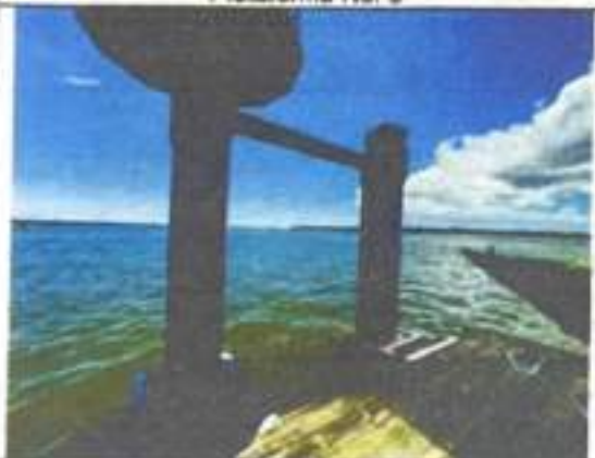
Pilotes y rodillos Plataforma No. 3
