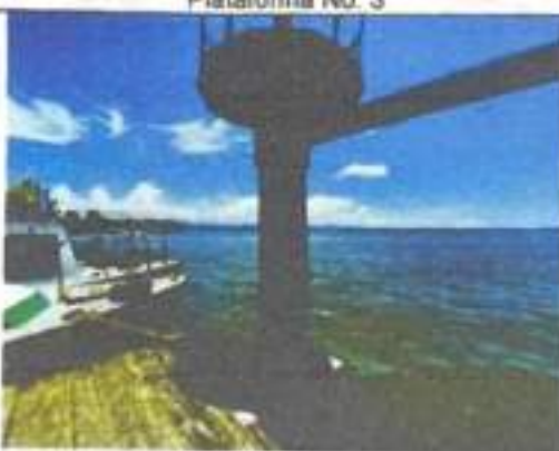
Pilotes y rodillos Plataforma No. 3
