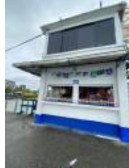
Pasarela - Torre de Control
