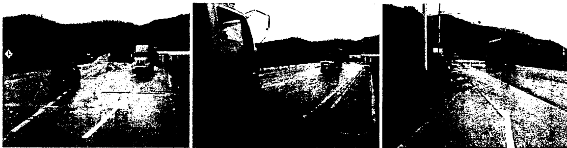
Ilustración 6. Problemas de seguridad vial Estación de Pesaje Botana.
