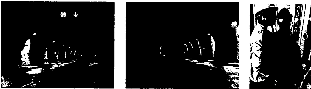
Ilustración 2. Problemas de ventilación y comunicación Túnel Daza.
