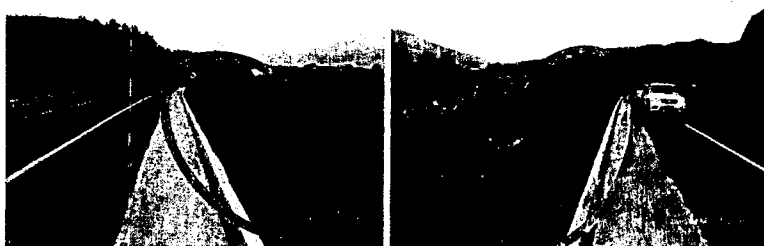
Ilustración 8. Ausencias de barreras metálicas en diversos tramos del proyecto.
