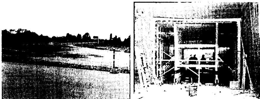
Ilustración 5. Avance físico construcción T de Portachuelo.
