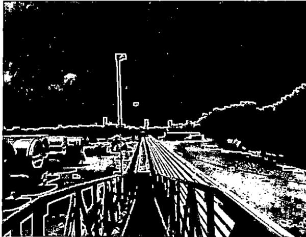
Se verificó la pasarela de acceso a la plataforma de atraque, soportando la línea contraincendios, tubería de transferencia del buque a los tanques de almacenamiento y viceversa, línea de sistema eléctrico y luminarias, según se registra en el inventario.
