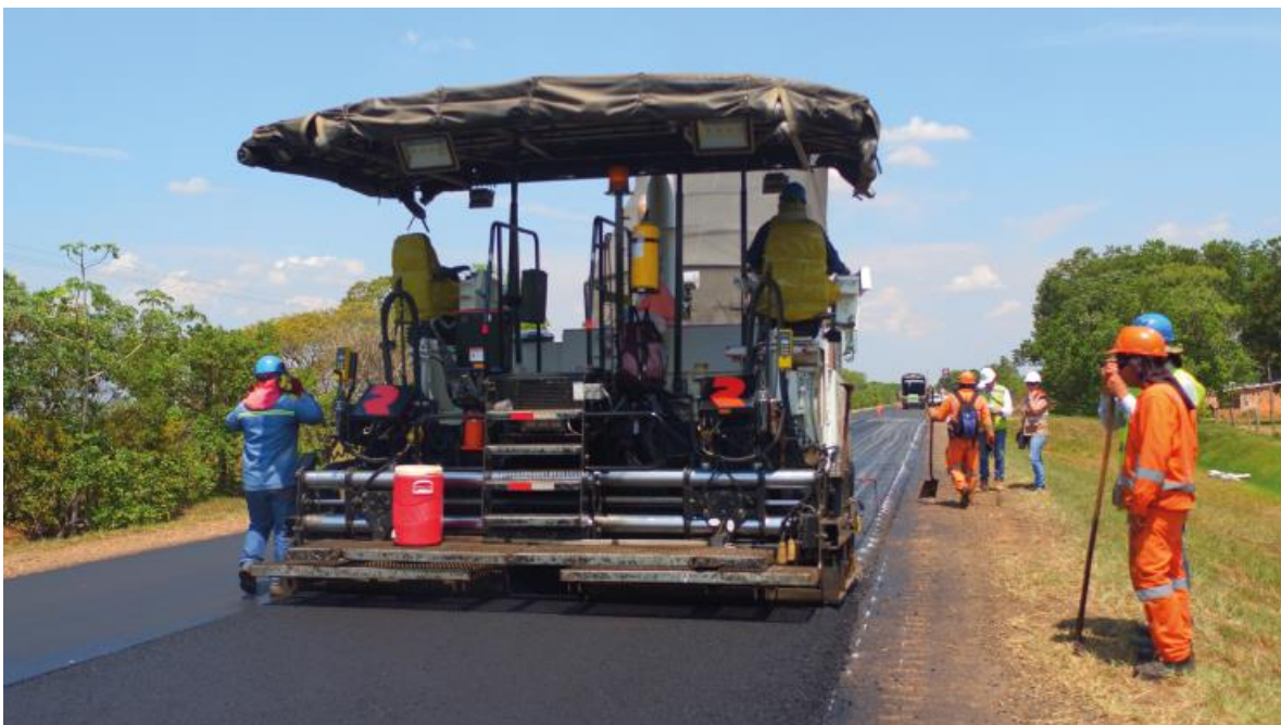
Avanzan obras en la vía Puerto López
