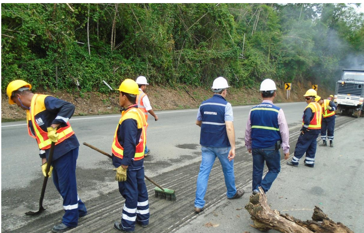
Personal operativo realizando trabajos en la vía Pacífico 2.
