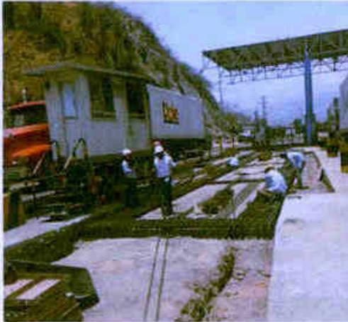
Foto 12. Cierre de obra, arme de refuerzos de acero y disposición de material de excavación.
