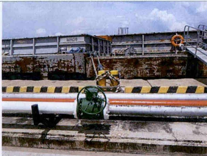
Foto 8. Detalle de bitas de amarre.
