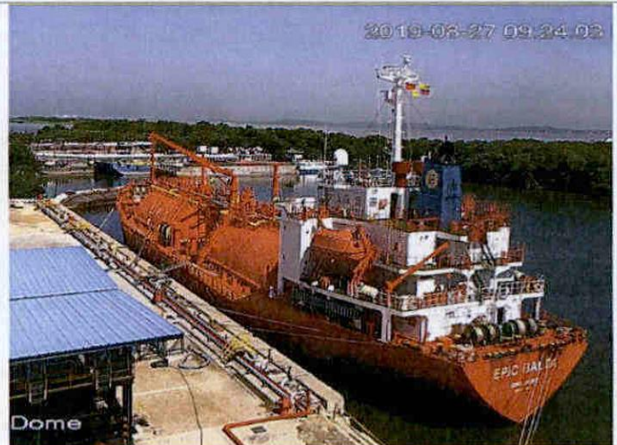
Foto 2. Operación de la infraestructura portuaria.
