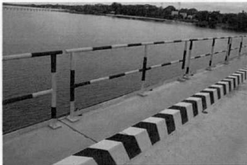
Foto 13. Protección lateral en buen estado
