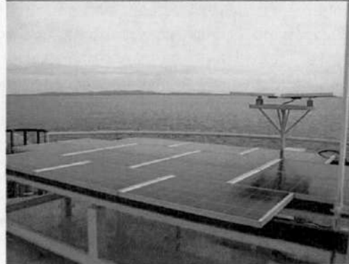
Foto 20. Paneles solares TLU 1
