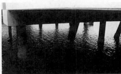
Foto 15. Panorámica cimentación del muelle
