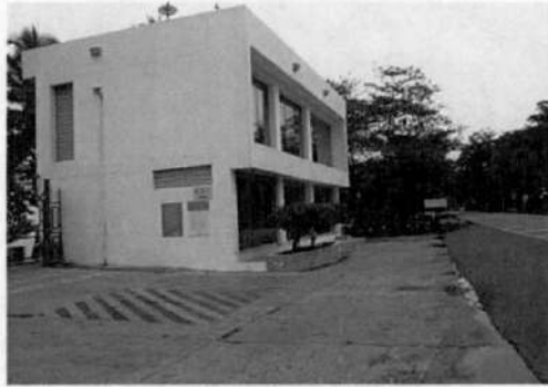
Foto 3. Fachada oriental edificio administrativo.
