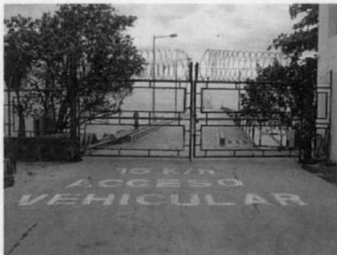
Foto 9. Cerramiento acceso vehicular
