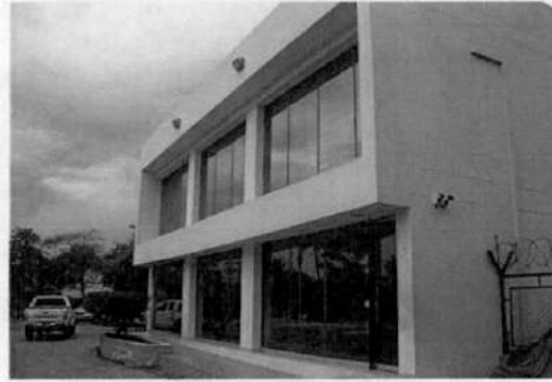
Foto 4. Fachada occidental edificio administrativo
