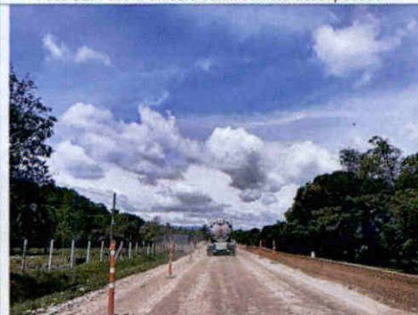
Foto 31. Paso a un solo carril con vía descapotada.
