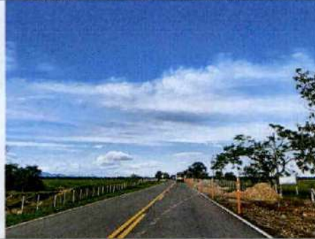
Foto 19. Frente de obra abierto sin intervención.
