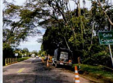
Foto 12. Actividades de mantenimiento en puente.
