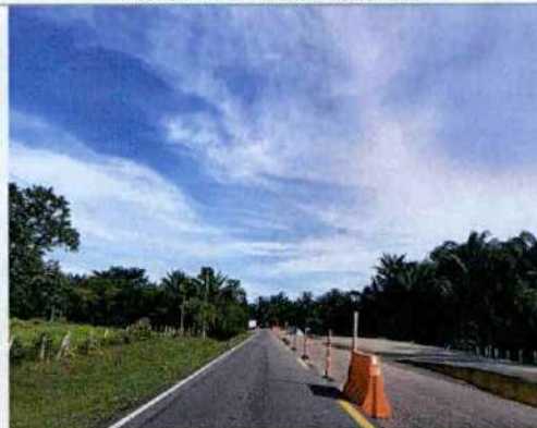
Foto 16. Frente de obra sin actividad.
