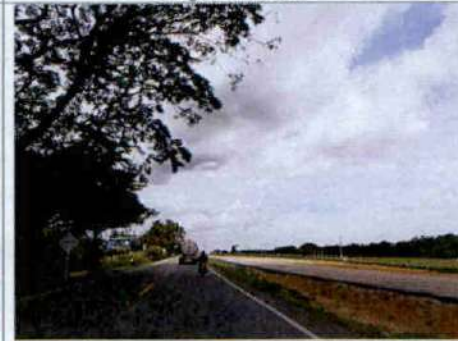
Foto 37. Conformación de base para construcción de segunda calzada.
