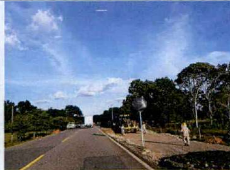
Foto 21. Ampliación de calzada con frente de obra activo.
