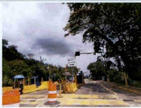
Foto 5. Peaje Puente Amarillo.
