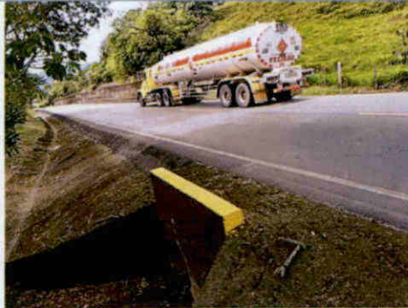
Foto 26. Pintura de cabezote, vista lateral.
