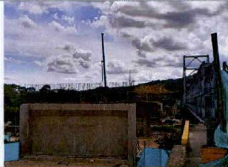
Foto 41. Construcción del nuevo puente Charte.
