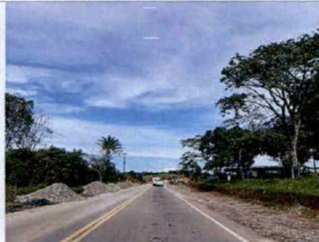
Foto 13. Falta de señalización PMT.
