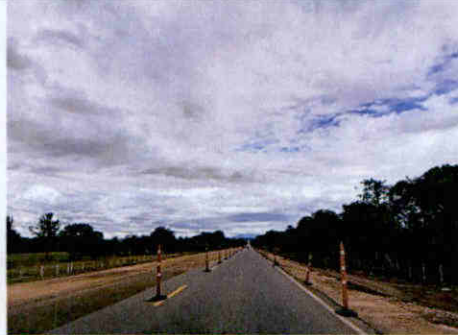
Foto 23. Paso a un solo carril sin ejecución de actividades constructivas.
