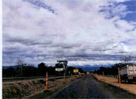
Foto 22. Paso a un solo carril, ejecución de actividades de excavación.
