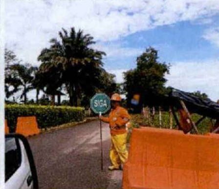
Foto 4. Paso a un solo carril según PMT de la UF1.
