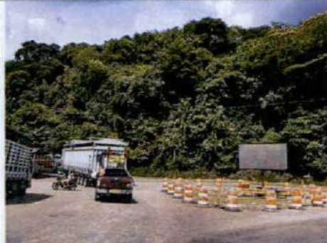
Foto 34. Intersección Unete en operación.
