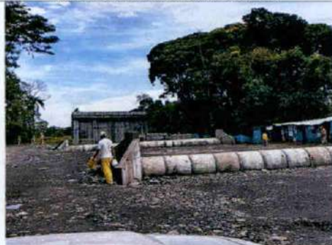
Foto 7. Construcción de obras hidráulicas.
