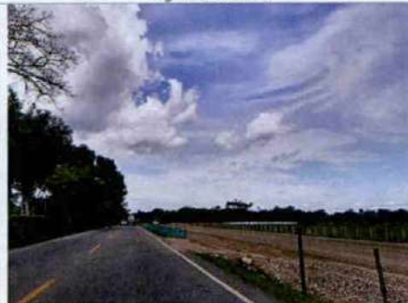
Foto 36. Conformación de subbase para construcción de segunda calzada.
