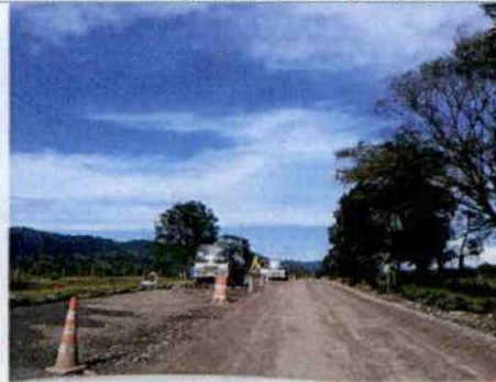
Foto 14. Retiro de pavimento en la vía en operación.
