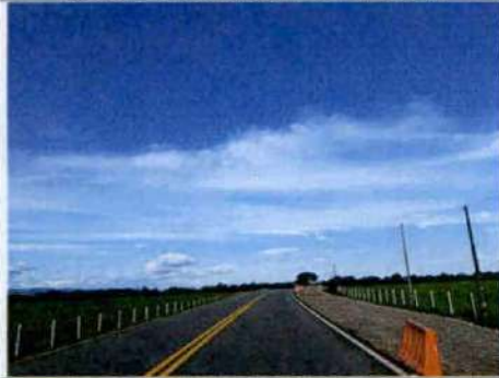
Foto 18. Frente de obra abierto sin intervenir.
