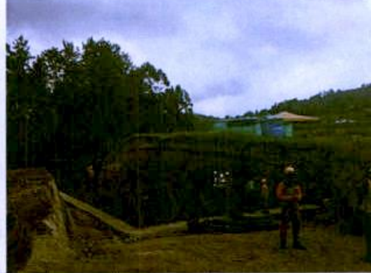
Foto 6. Frente de obra de cimentación del puente Boquerón.
