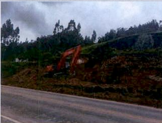
Foto 3. Actividades de excavación de taludes.
