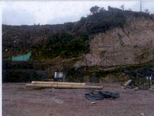
Foto 4. Cimentación profunda del puente Boquerón.
