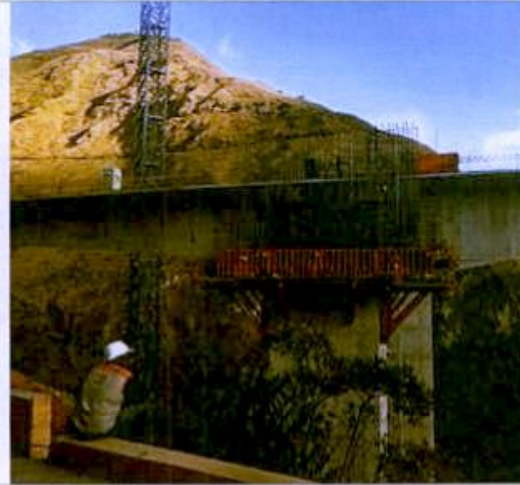
Foto 24. Construcción de la margen izquierda del puente Guaitara.
