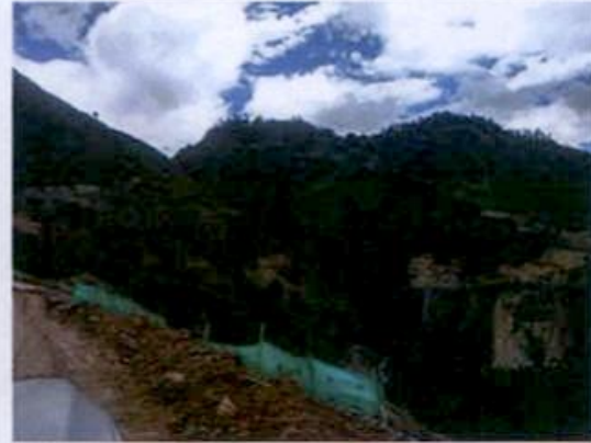
Foto 12. Ubicación del futuro puente El Macal.
