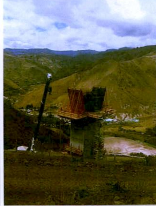
Foto 16. Vista superior de la pila 1 del puente El Porvenir.
