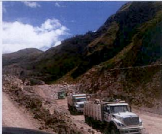
Foto 14. Movimiento de tierras en las vías de acceso al puente Tablón Alto.
