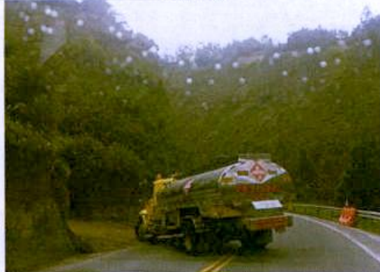
Foto 5. Acceso al frente de obra de cimentación del puente Boquerón.
