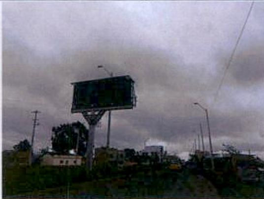
Foto 1. Panel LED en funcionamiento.
