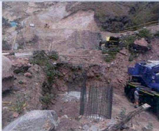
Foto 13. Cimentación del puente Tablón Alto.
