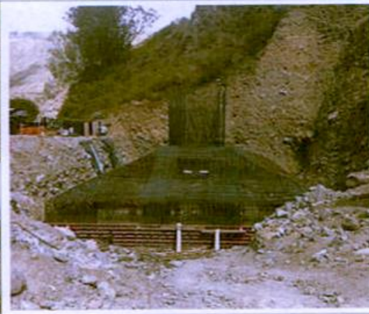
Foto 18. Refuerzo de zapata en el puente Sapuyes.
