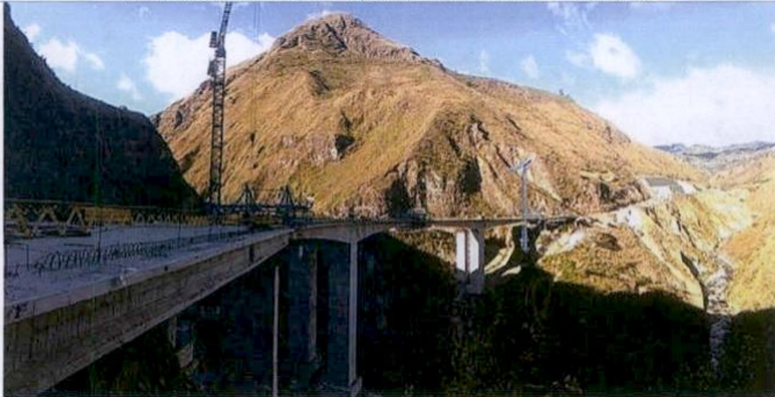
Foto 22. Avance de construcción del puente Guáitara en la calzada derecha (UF4).
