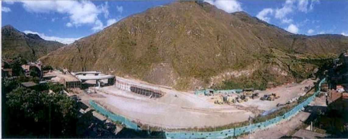
Foto 21. Avance de construcción de la Glorieta en el sector de Pedregal (UF4).
