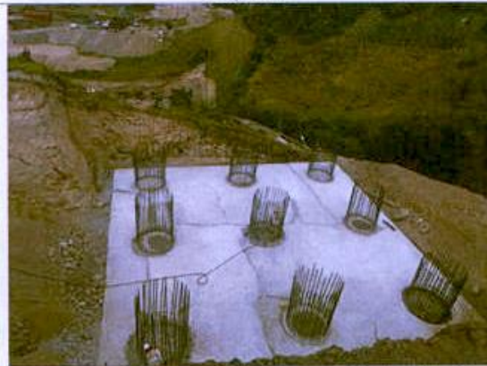
Foto 7. Cimentación para la instalación de pilas del puente Boquerón.
