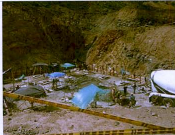
Foto 17. Avance de cimentación Pila 2 puente Sapuyes.
