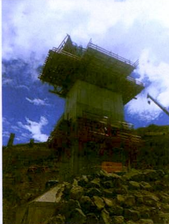
Foto 15. Pila 1 puente El Porvenir.
