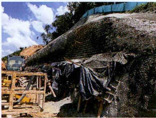
Foto 3. - UF1 – Estabilización de taludes
