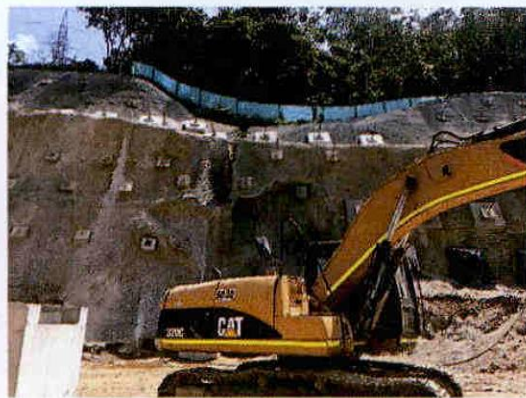
Foto 4. - UF1 – Estabilización de taludes.
