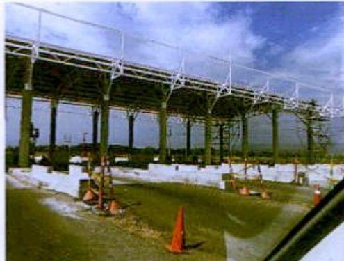
Foto 40. UF5 - Instalaciones Peaje Flandes
