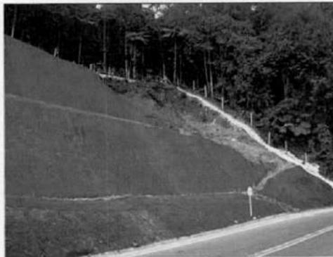
Se evidenciaron avances en la revegetalización, principalmente en proximidades a la pata del talud. En los sectores aledaños a las estructuras de sacos suelo cemento se evidenció aún erosión.
