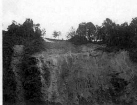
Se evidenció el resultado de retiro de material y de perfilado del talud. En la parte superior se evidenciaron actividades de extensión de geomanto.
