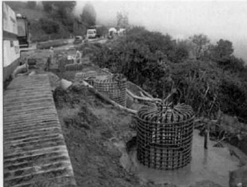
Se evidenciaron actividades de vaciado de concretos como parte de las actividades para la construcción de pilotes.
