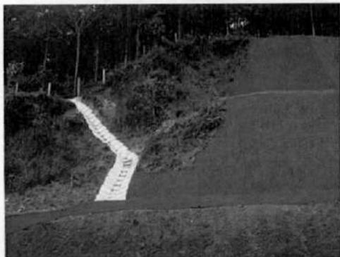
En la fotografía se muestra el resultado de corte de talud, conformación de terrazas intermedias, estructura de entrega de aguas en sacos suelo cemento y protección de superficie del talud.
