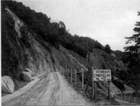
En el sector del PR22 se evidenció que se ha retirado material en riesgo de caída, perfilado de taludes e instalación de hidrosiembra.
