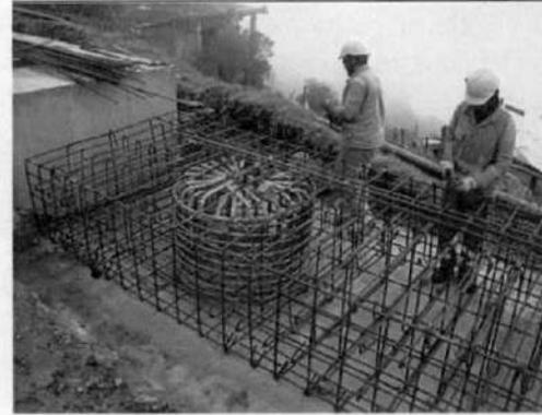
Se evidenciaron avances en la construcción de los módulos de la viga cabezal.
