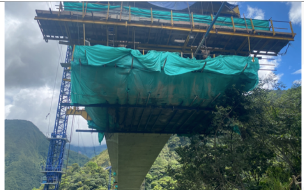
Foto 6. Avance construcción estribo Villavicencio.
