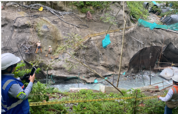
Foto 7. Estabilización ladera quebrada Chirajara.
