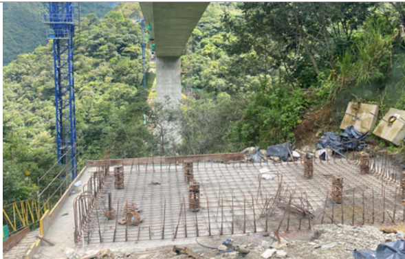
Foto 5. Avance construcción estribo Villavicencio.
