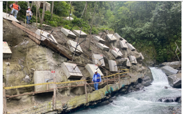
Foto 8. Estabilización ladera quebrada Chirajara.
