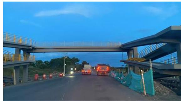
Se evidenció construcción de superestructura en concreto, y se encuentra en fase de instalación de barandas.
