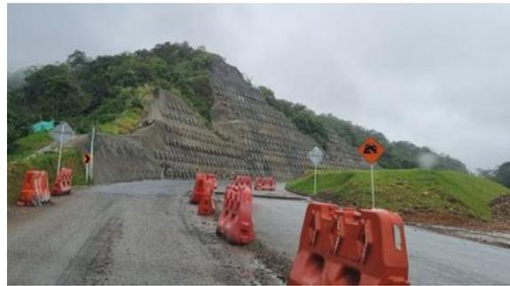
Se evidencia tramo con estabilización de taludes finalizada y ejecución de ampliación de calzada.
