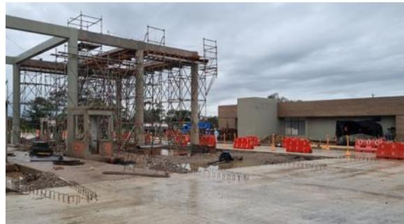
Se evidencia losas de área de recaudo pendientes y ejecución de cubierta.
