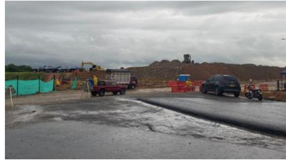
Se evidenció conformación de terraplén en el costado derecho de la intersección para aproximación al futuro puente sobre el corredor.
