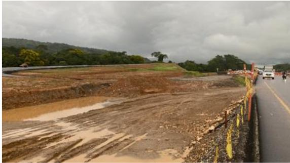
Se evidenció movimiento de tierras correspondiente a construcción de segunda calzada en el costado izquierdo y pavimentación de enlace al futuro puente sobre el corredor vial.
