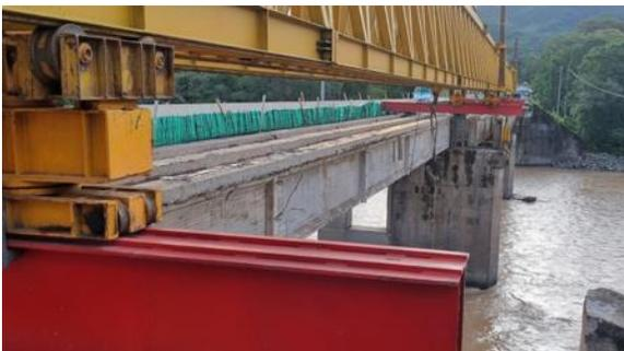
Sistema de remoción de vigas mediante desplazamiento con estructura de apoyo.
