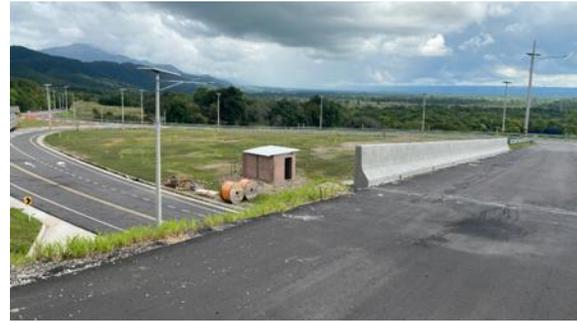
Se evidenció capa de rodadura del puente vehicular finalizada; está pendiente liberación de predios para finalizar la intersección.
