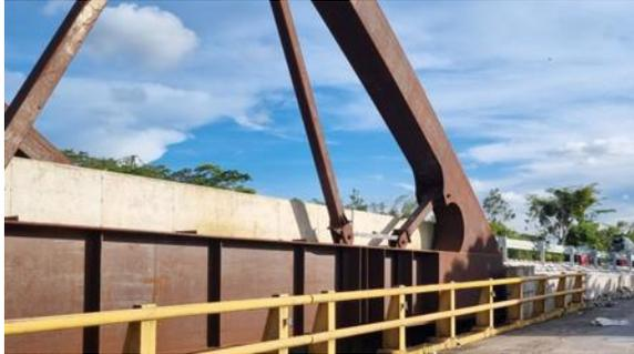
Se observa finalización de estructura metálica lateralmente a pontón existente.
