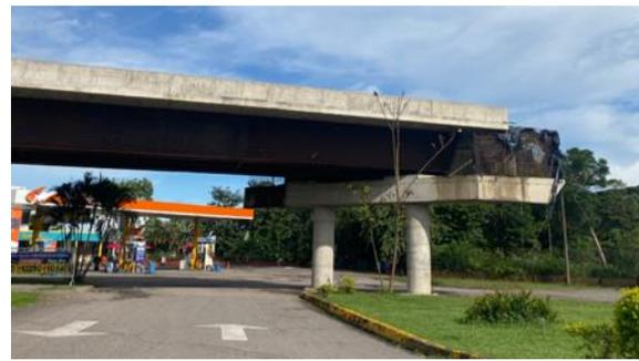
Se evidenció la construcción del pontón, se finalizó el tablero y se encuentra pendiente la finalización con barandas y señalización.
