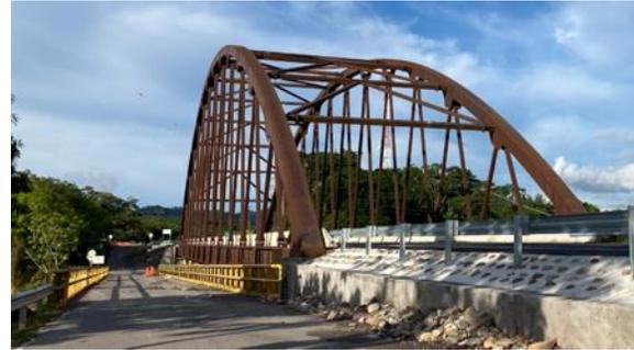
Se observa finalización de estructura metálica, tablero, apoyos, estribos y barreras en la aproximación a la estructura.
