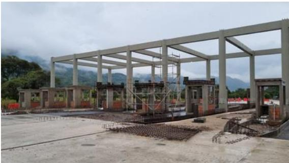
Se evidencia construcción de estructura de cubierta y cabinas de peaje.
