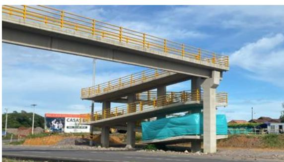
Se evidenció estructura finalizada e instalación de barandas, está pendiente la realización de la rampa de empalme y la construcción urbanismo.
