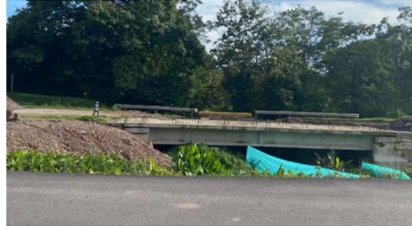
Se evidenció la construcción del pontón, se finalizó el tablero y se encuentra pendiente la finalización con barandas y señalización.
