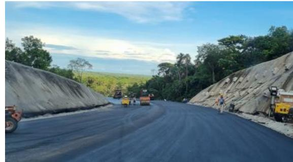
Se evidenció la colocación de la capa de rodadura en la parte final del Alto de la Guala.
