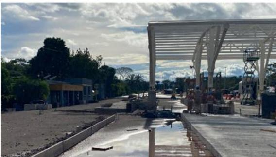
Se evidencia en la parte izquierda infraestructura entregada en el año 2015 de operación provisional, y ejecución de la cubierta de la estación de peaje, así como las losas de ingreso respectivas.
