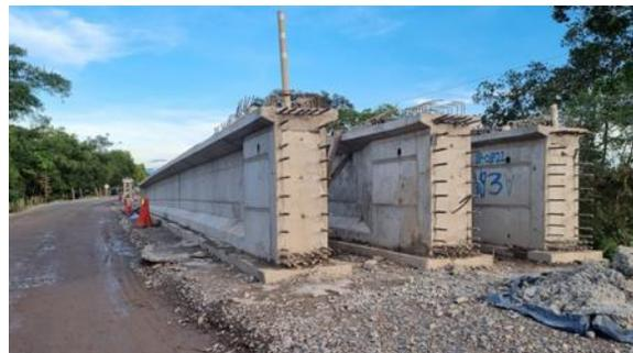
Vigas postensadas finalizadas y puestas a disposición para instalación en la repotenciación del puente.
