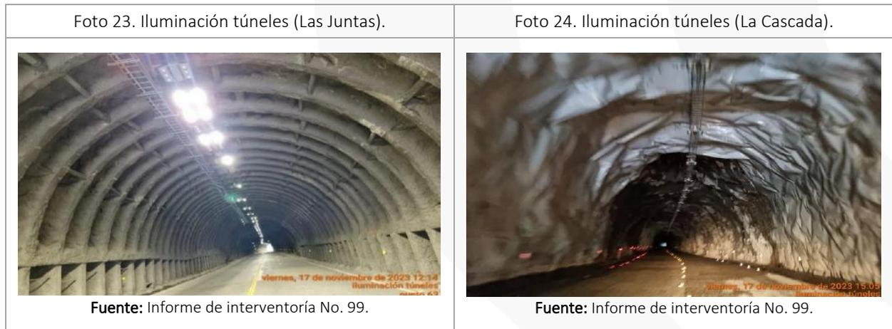
Según lo reportado en el informe de interventoría No. 99 “El corredor vial denominado Transversal del Sisga cuenta en su trayectoria con 15 túneles con una longitud aproximada de 7.224 m, de los cuales 14 (a excepción del túnel el Trapiche con una longitud aproximada de 91 m) cuentan con sistema de iluminación.
