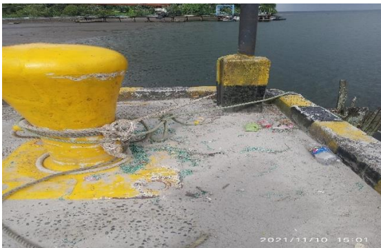
Foto 1. Infraestructura actual del puerto
