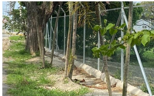
Se evidencia la finalización de la renovación del cerramiento del costado oriental en malla eslabonada recubierta en PVC en cumplimiento del RAC 160 – (Reglamentos Aeronáuticos Colombianos – Seguridad de la Aviación Civil)
