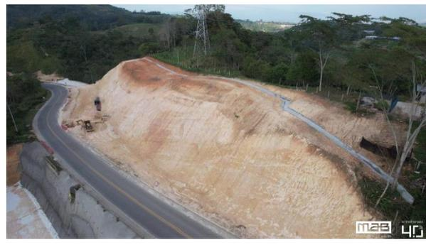
Con base en el registro fotográfico general del informe de la Interventoría Consorcio BBY remitido a la Oficina de Control Interno mediante correo electrónico del 10 de marzo de 2023, se evidencian avances en explanaciones, estabilización y empedrado de taludes, construcción de pavimentos y servicio de una calzada de la UF9.
