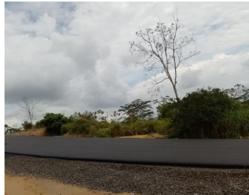
Foto 11. UF9 – Mezcla asfáltica PK114
