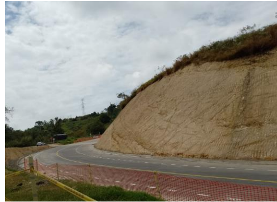
Foto 13. UF9 – Vía terminada PK114
