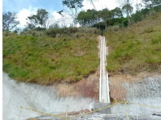
Foto 9. UF9 – Drenaje transversal PK112+900
