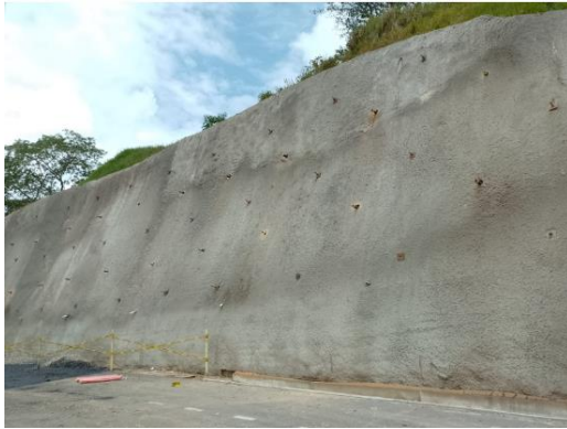
Foto 8. UF9 – Protección de taludes PK112+900
