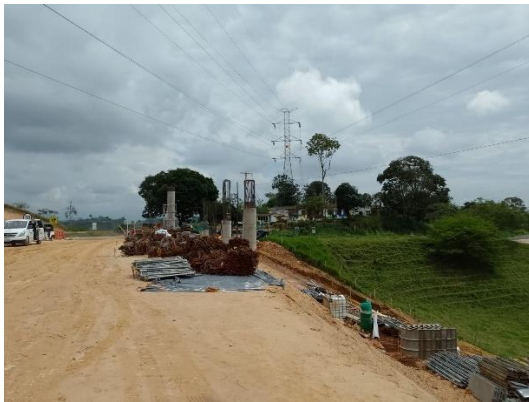
Foto 6. UF9 – Puente peatonal sector Mirabel PK111+400
