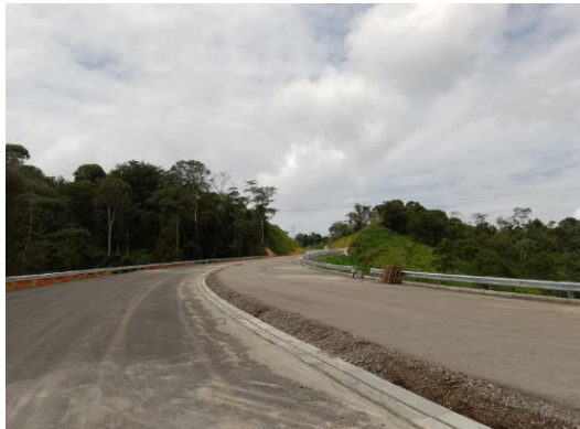
Foto 10. UF9 – Defensas metálicas PK111+900
